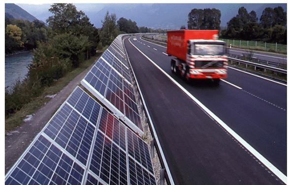
**Anlagentyp „aufgesetzt“.** Bei diesem Typ werden die PV Module oben auf die Schallschutzwand mittels einer Tragkonstruktion aufgesetzt. Erstmals weltweit 1989 in der Schweiz durch TNC geplant und vom Bund realisiert an der A13 bei Chur.
