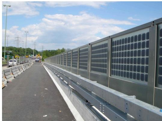
**Anlagentyp „bifacial“.** Bei diesem Anlagentyp werden die Module in Nord-Süd-Richtung (also mit Ost-/West-Ausrichtung) installiert. Sie substituieren die Lärmschutzelemente vollständig. Im Bild ein Beispiel auf einer Autobahnbrücke im Grossraum Zürich.
