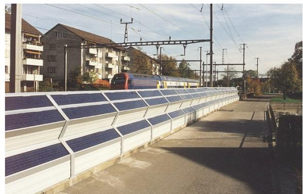
**Anlagentyp „ZickZack“.** Die Lärmschutzwand und die PV Module sind in einem Zick-Zack Muster aufgebaut um die Höhe der Lärmschutzwand besser ausnutzen zu können. Hier ein Beispiel an einer Bahnlinie im Grossraum Zürich.
