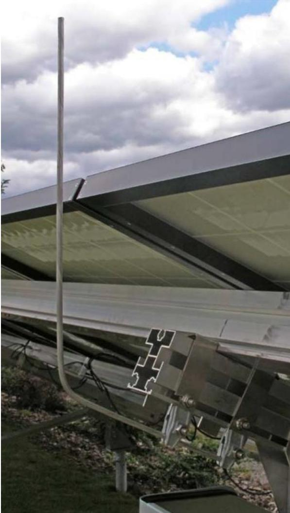
**Bild 3:** Blitzstromfeste Anbindung eines Modulgestells
