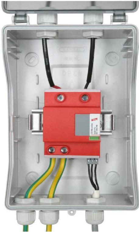
**Bild 10:** Spannungsbegrenzender Typ 1 PV-SPD mit Ableitvermögen entsprechend DIN EN 62305-3 Beiblatt 5
